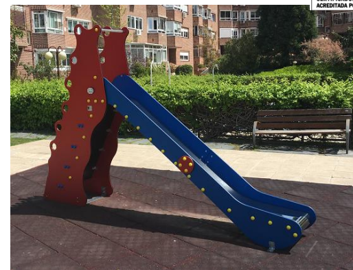
Superficie hormigonada con suelo protector de caucho
